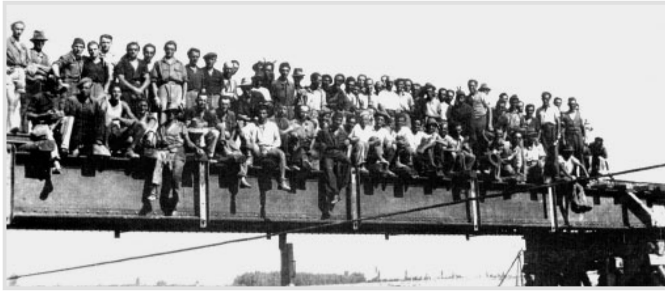
Le maestranze addette alla ricostruzione del ponte sul fiume Oglio fra Bozzolo e Marcaria, avvenuta fra il 1945 e il 1946. Fotografia. Bozzolo, 22 settembre 1945.
