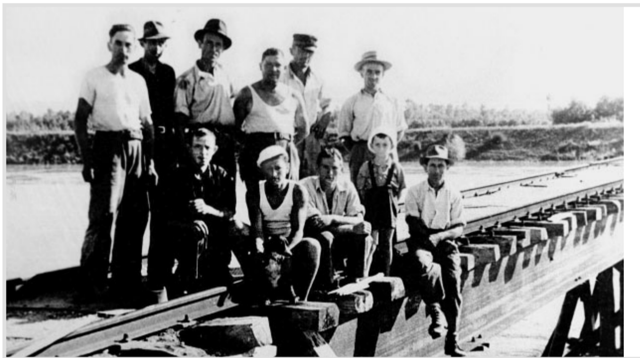
Operai in un momento di pause dal lavoro di ricostruzione del ponte sul fiume Oglio. Secondo in alto da sinistra Giovanni Ronca, primo in basso da sinistra Giuseppe Finardi. Fotografia. Bozzolo, 22 settembre 1945.
