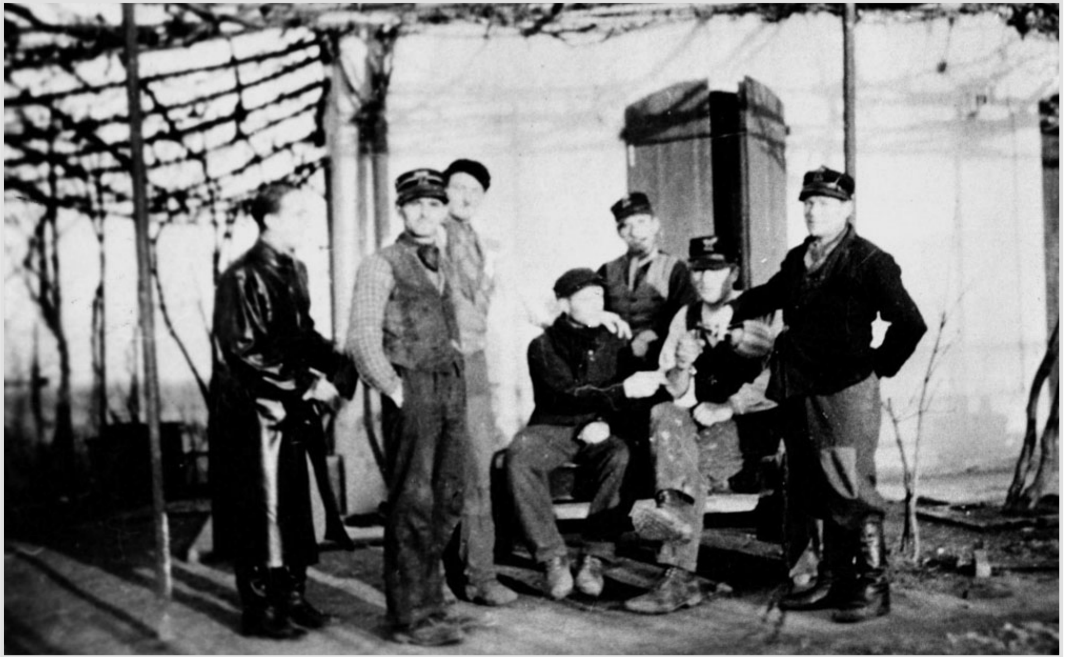
Gruppo di ferrovieri presso il casello del passaggio a livello di Bozzolo. Fotografia. Bozzolo, 1937 circa.
