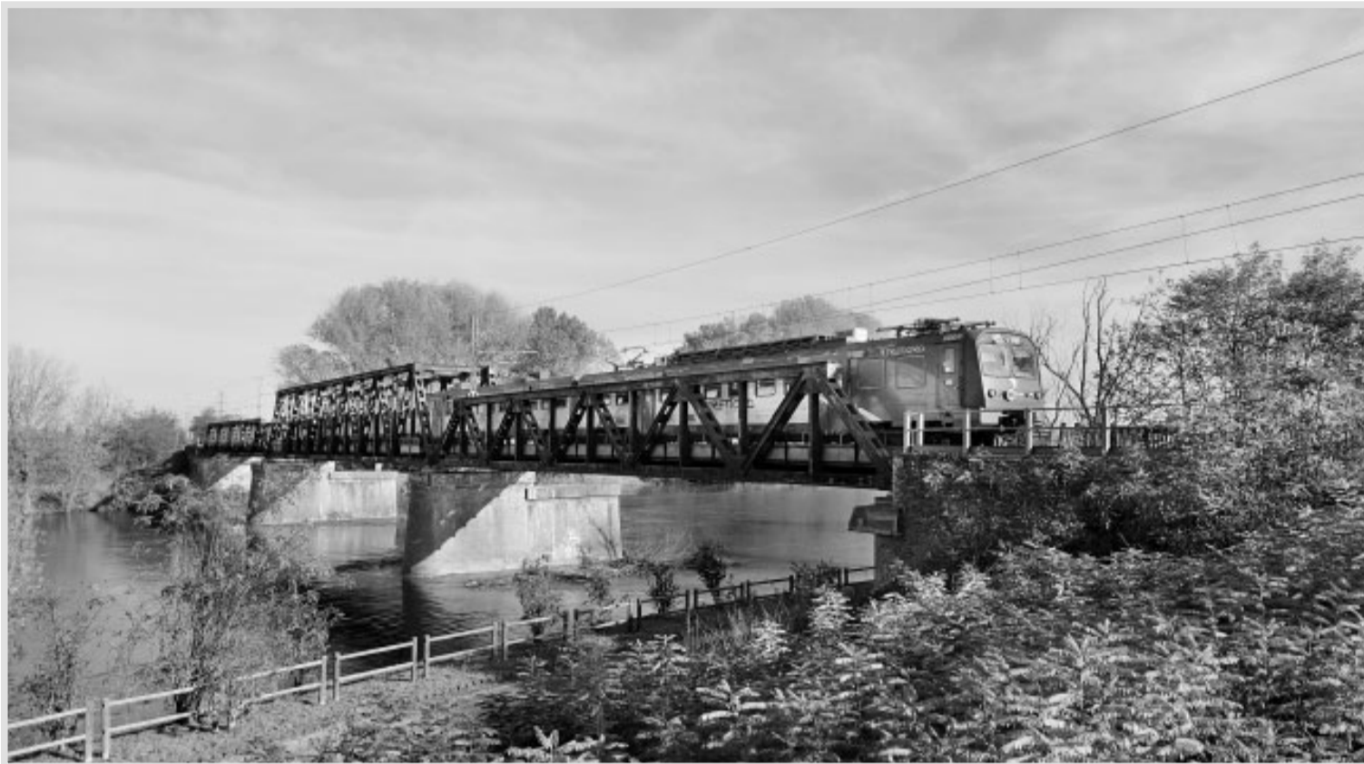
Un treno percorre il ponte sul fiume Oglio, ricostruito tra il 1945 e il 1946, verso la stazione di Bozzolo. Fotografia di Fabio Cavaglieri. Bozzolo, 18 novembre 2023.
