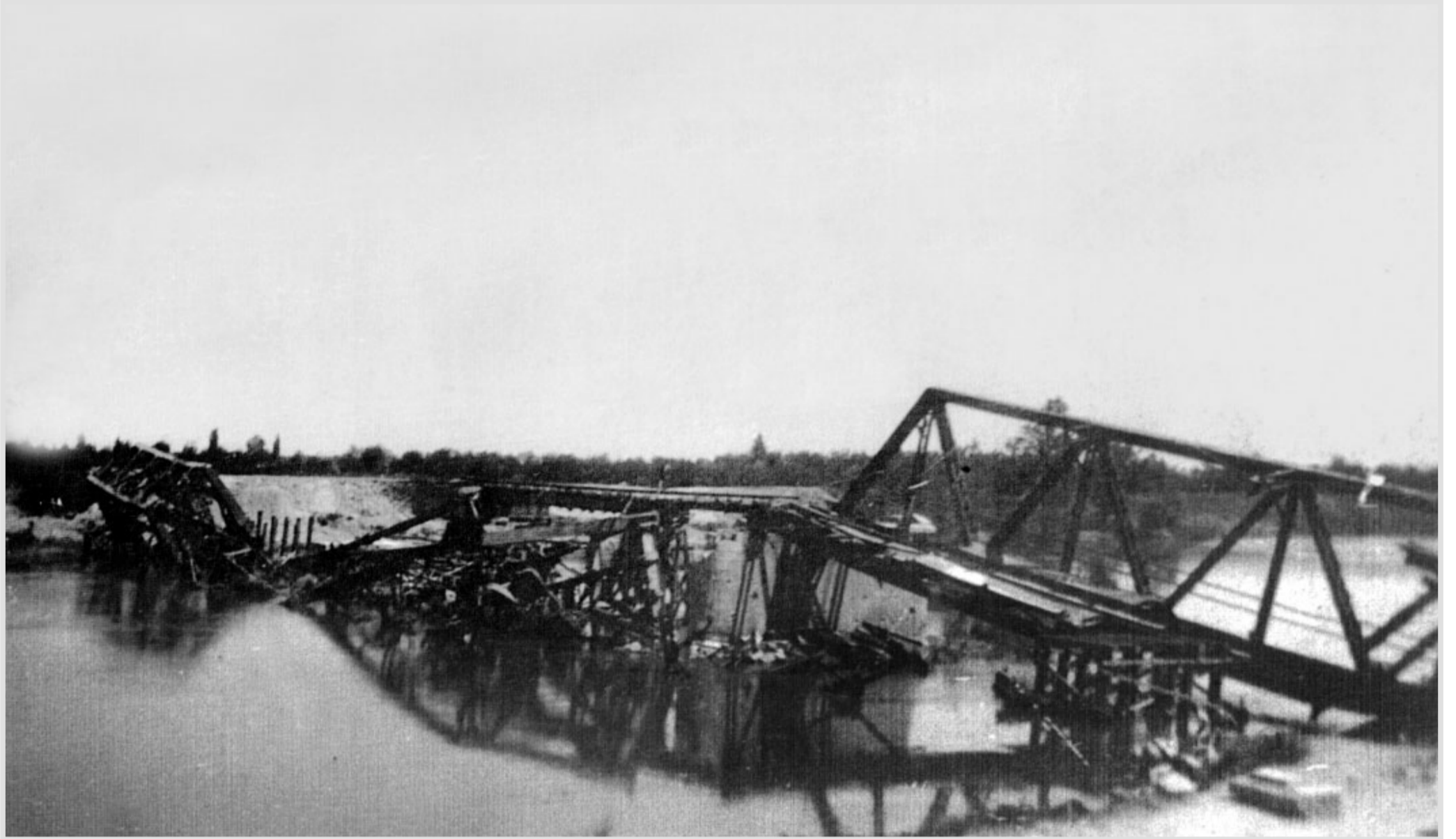
Il ponte sul fiume Oglio fra Bozzolo e Marcaria, distrutto da uno dei vari bombardamenti aerei nel corso del 1944. Fotografia di Luigi Pagliari, Bozzolo, 1944.
